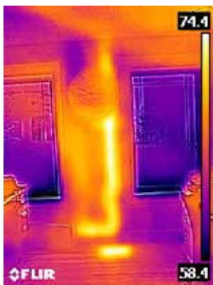
Теплая отводная труба в стене
