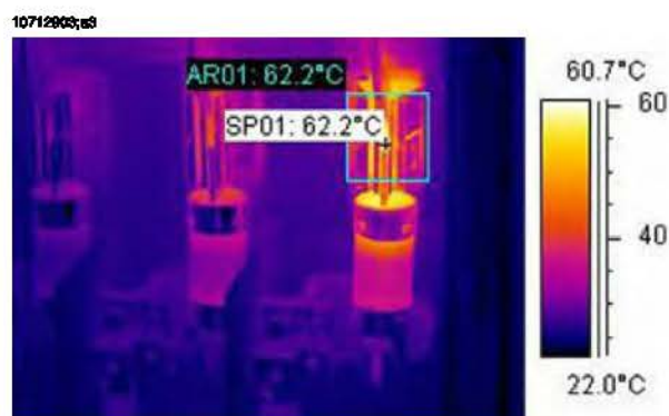
Рисунок 28.3 ИК-изображение блока предохранителей с указанием значения максимальной температуры
