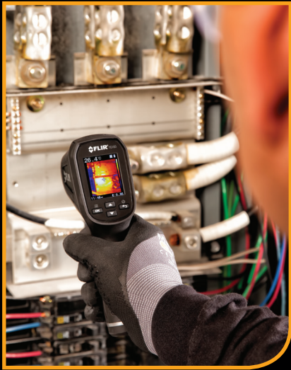
Проверка электрооборудования
