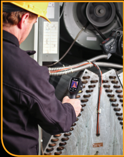
Проверка системы отопления
