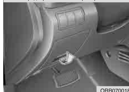
Панель предохранителей на приборной панели
