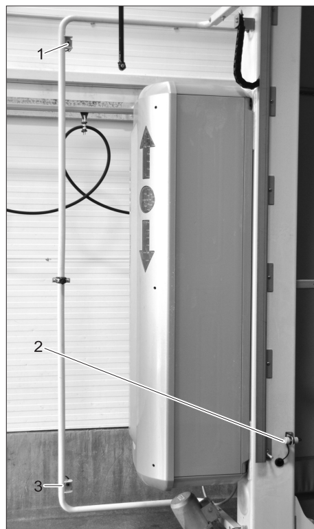
Obr. 2 1 Světelná závora poloha 2 nahoře 2 Koncový spínač střešního kartáče dole (SKD) 3 Světelná závora poloha 2 dole
