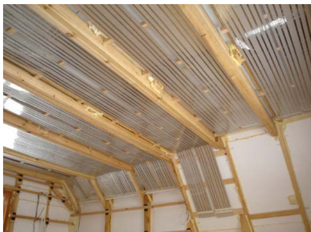
Рис. 11, 12. Крепление пленочных электронагревателей с закрытием деревянным потолком (вагонкой).
