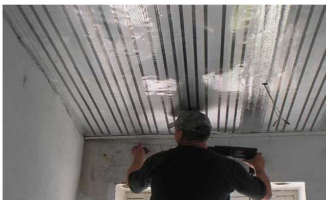
Рис. 9. Процесс крепления нагревателя
