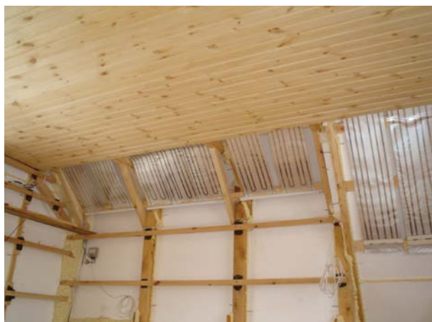
Рис. 11, 12. Крепление пленочных электронагревателей с закрытием деревянным потолком (вагонкой).
