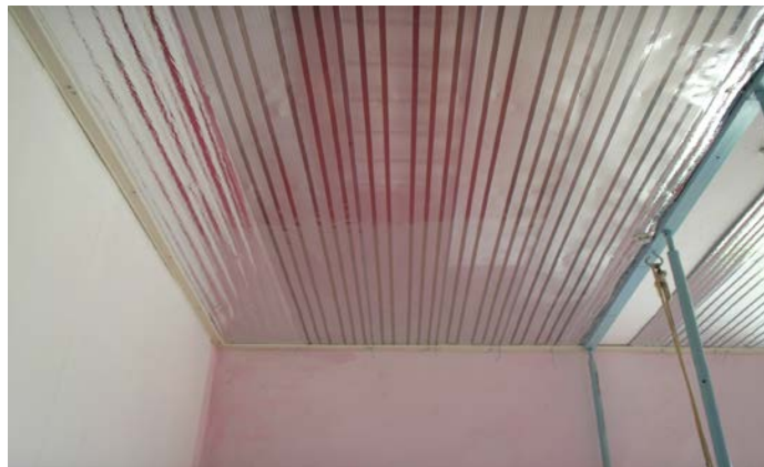
Рис. 8. Общий вид закрепленных электронагревателей
